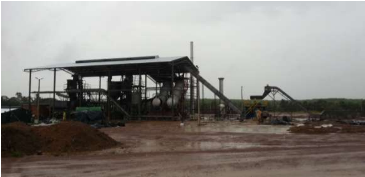
Foto 2. Planta extractora en la plantación Los Macondo.
